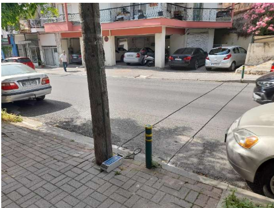
Εικόνα 6.1: Εγκατεστημένος αυτόματος μετρητής κυκλοφορίας
